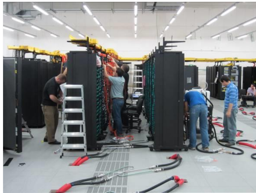
Warmwasserfüllung der Racks
